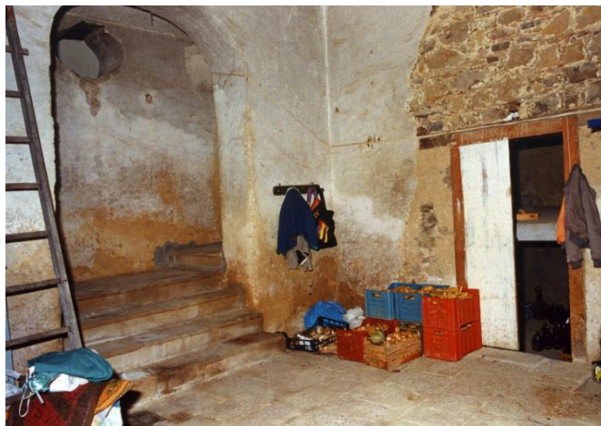
“Casino del Cardinale Mariosa”. Vano d’ingresso. I quattro gradini, sulla sinistra, immettono in un corridoio, che, nella direzione verso sinistra, mena alla cappella, mentre nella direzione a destra, superato un gradino, porta prima ad una cucina, poi ad un salone. Prima dell’entrata alla cucina, parte la scala, che mena al piano superiore. Continuando ad osservare il disimpegno, vediamo di fronte a noi una porta aperta a metà. Essa dà su un pianerottolo, al quale una volta seguiva uno scivolo con un’inclinazione del 25% circa, che serviva per far scendere i cavalli nella stalla, dove erano tenuti al sicuro sotto lo stesso tetto. Nella parete di rimpetto si apriva dall’interno l’accesso alla cappella. In questa foto non si vede perché è fuori campo.
