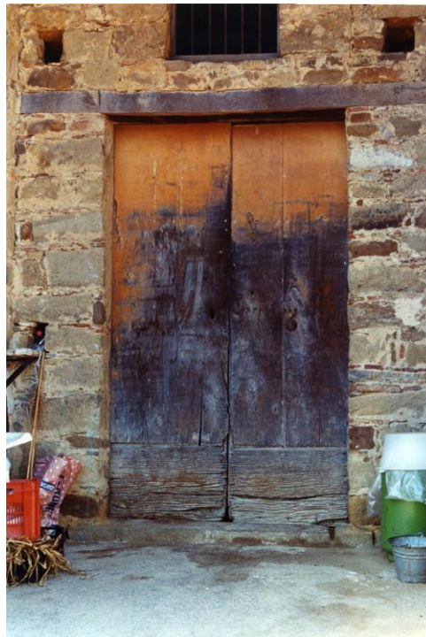
“Casino del Cardinale Mariosa”: il portone principale. Sono ben visibili le due “feritoie”, poste sulle estremità dell’architrave, comunemente chiamate “saittere” (da “sagitte”, “freccce”). Servivano a respingere dall’interno gli eventuali assalti di ladri soprattutto notturni.
